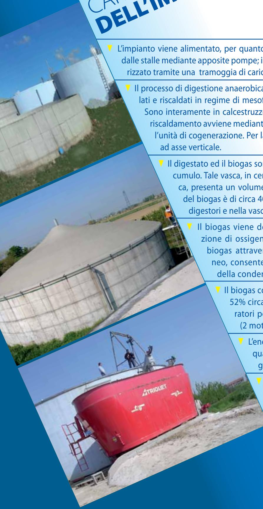
▼ L'impianto viene alimentato, per quanto riguarda gli effluenti zootecnici, direttamente dalle stalle mediante apposite pompe; i materiali solidi vengono dosati in modo temporizzato tramite una tramoggia di carico dotata di trituratore.
