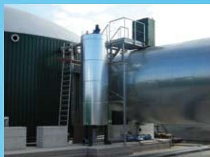
I **digestori "a secco"** sono adatti alla digestione di materiali con contenuto in sostanza secca superiore al 20% (es. letame, biomasse vegetali, ecc.). Sono per lo più diffusi nel settore del trattamento dei rifiuti solidi urbani.
